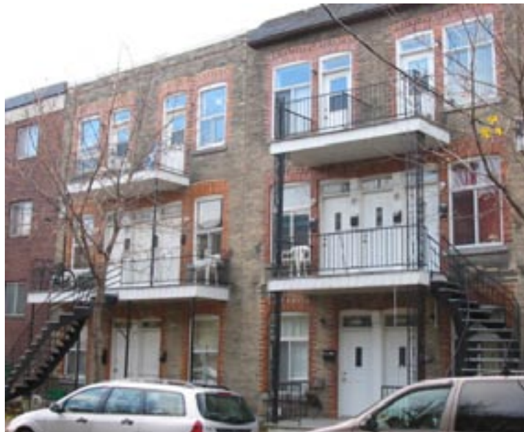
Des logements qui ont été complètement transformés, rue De Chambly.
