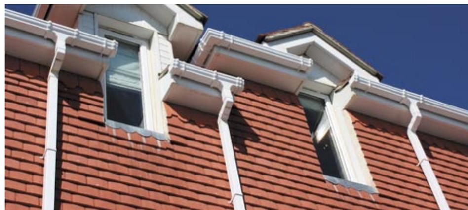
revêtements de toit ainsi que d'autres débris s'y accumulent, empêchant l'écoulement de l'eau. Si l'eau est retenue, sous l'effet du gel, elle risque de s'infiltrer par l'avant-toit et de provoquer une détérioration prématurée de la toiture.
