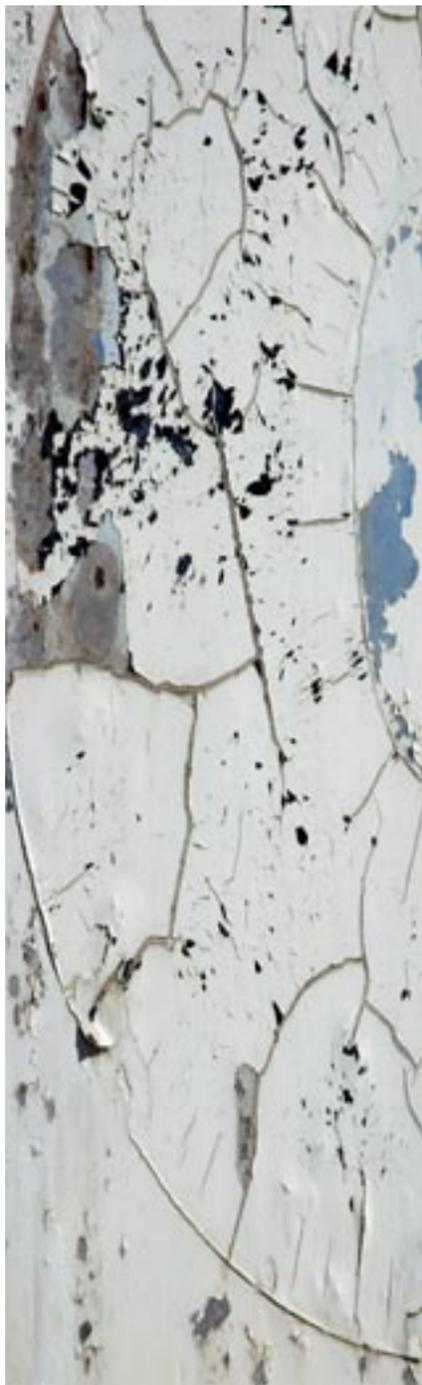
**A**vec le redoux du printemps, les maisons sont sujettes à des variations de températures et d'humidité. Le bois utilisé gonfle et sèche ce qui peut entraîner des fissures intérieures. Bien que le taux d'humidité idéal à l'intérieur d'une maison varie entre 40 et 45 %, le chauffage en période hivernale et la climatisation en été réduisent ce taux. L'assèchement de l'air ambiant qui en découle a un impact sur les matériaux utilisés dans la finition intérieure.
