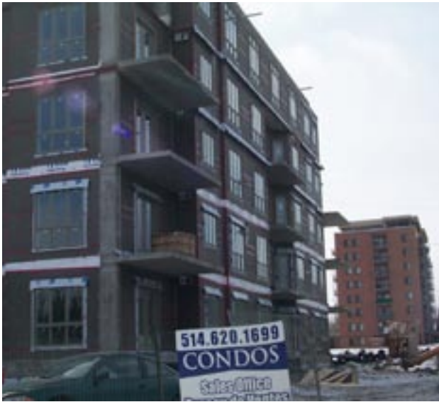
La construction de condominiums est toujours aussi populaire. Cette photo a été prise dans ce secteur de Pierrefonds, en pleine expansion.
